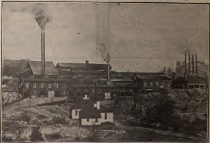
Bully Hill Smelter, De La Mar, Shasta Co., California.
